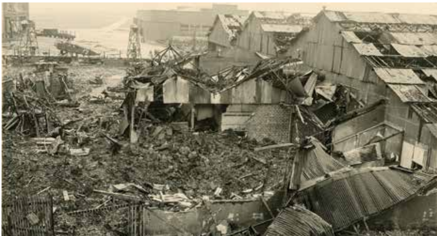
DESTRUCTIONS SUR LE SITE DE L'AÉROPORT DE BOURGES À LA SUITE DU BOMBARDEMENT ALLIÉ DU 10 AVRIL 1944. AD DU CHER, 117 J
